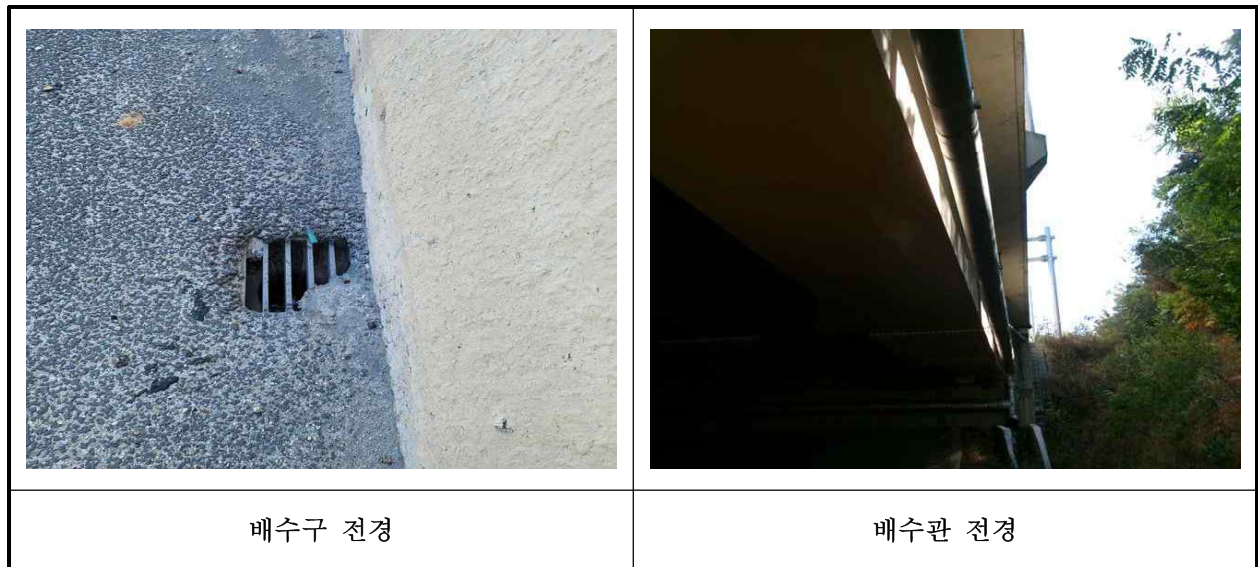
【사진 9.3.21】 배수시설 전경
