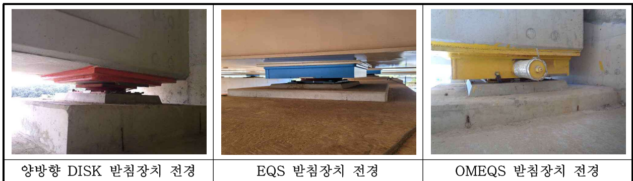
【사진 9.3.12】 교량받침 전경
