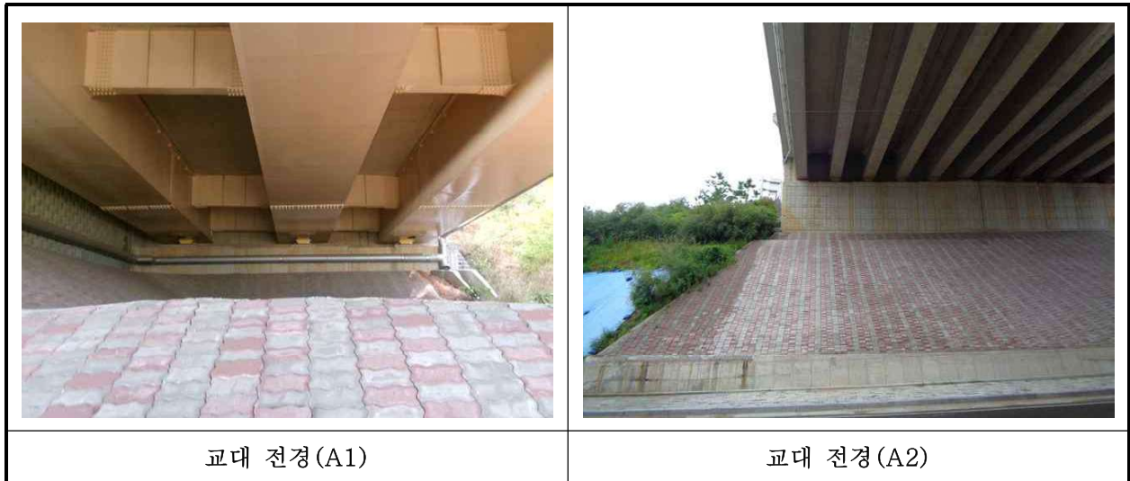
【사진 9.3.8】 교대 전경
