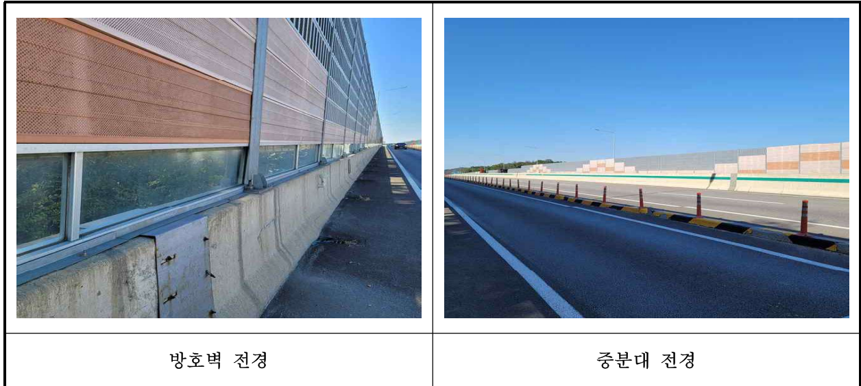
【사진 9.3.23】 방호벽 및 중앙분리대 전경
