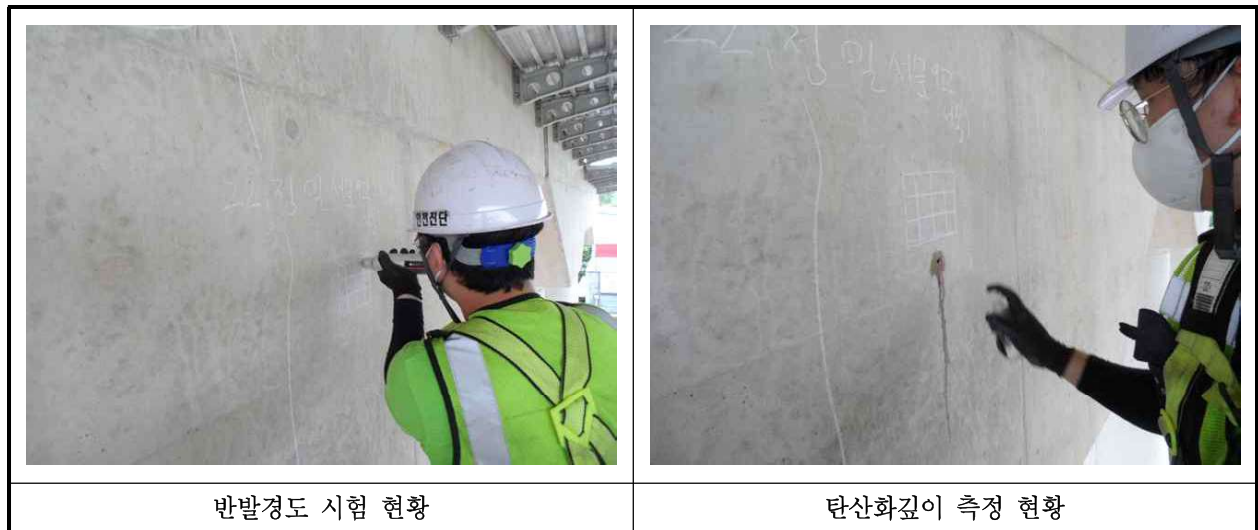
【사진 9.4.1】 콘크리트 내구성조사 현황
