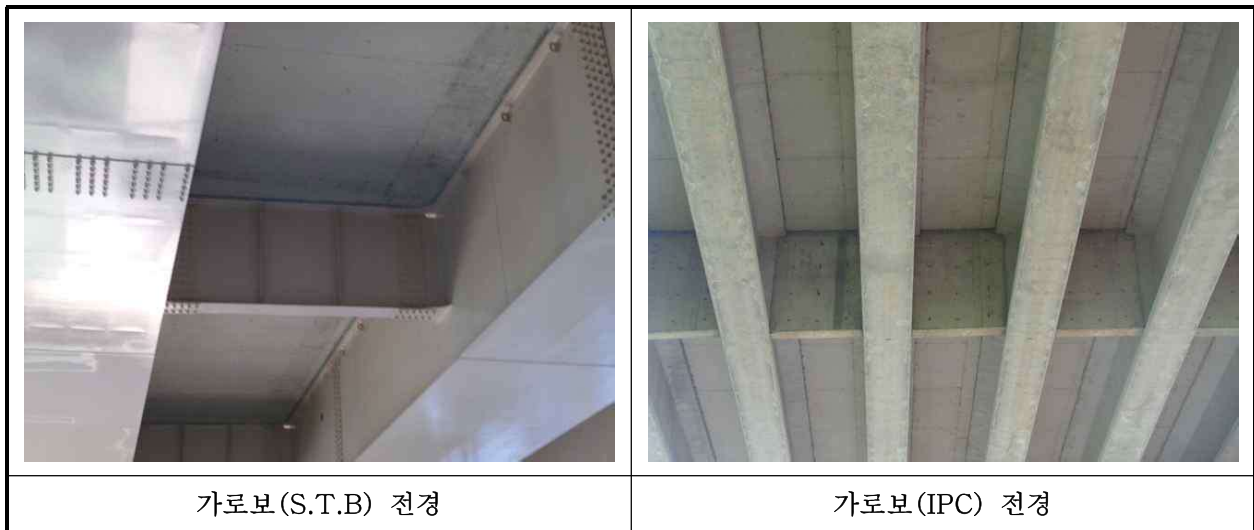
【사진 9.3.6】 가로보 전경
