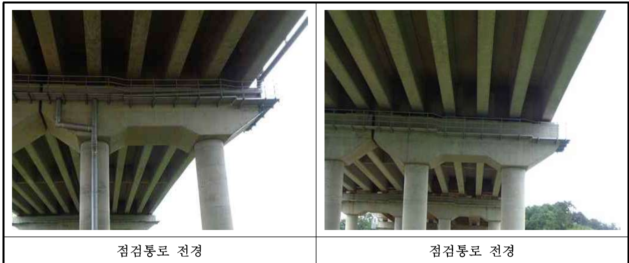
【사진 9.3.25】 교량 점검시설 전경
